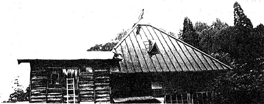
写真3-2 トタン屋根の煙出し
